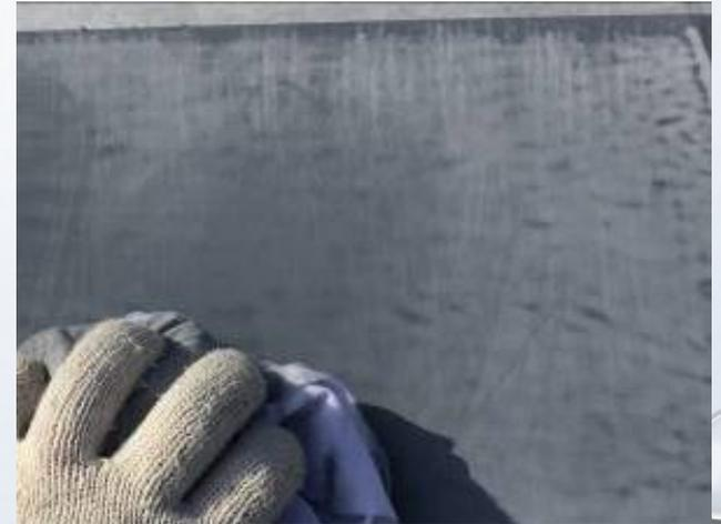
FRP防水面のトップコートに亀裂・ハガレ等の欠損がある場合は
