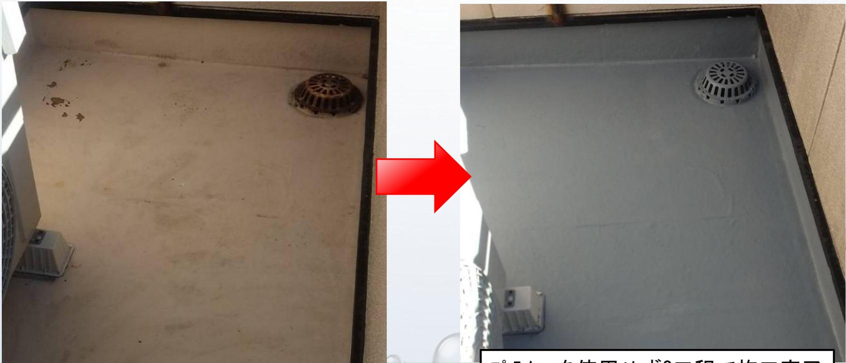
プライマーを使用せず2工程で施工完了
