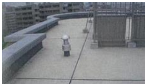
押えコンクリート
