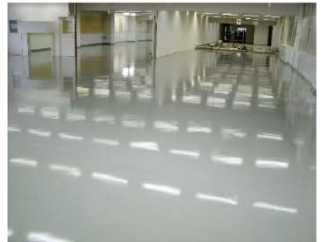
施工例②：工場床
