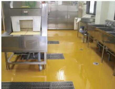
施工例①：厨房床
