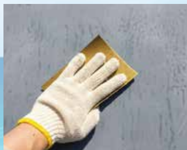
①FRP防水面を研磨します。
