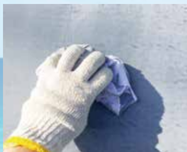
②研磨で発生した粉じんを取り除き、アセトンで全体を拭き取ります。
