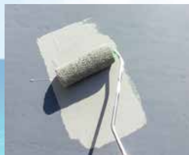
③フローンFRP防水面用アクアトップを塗布します。
