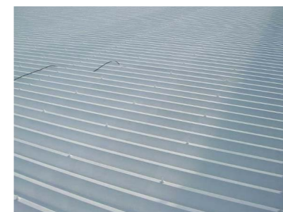
K社・工場(折板屋根)
