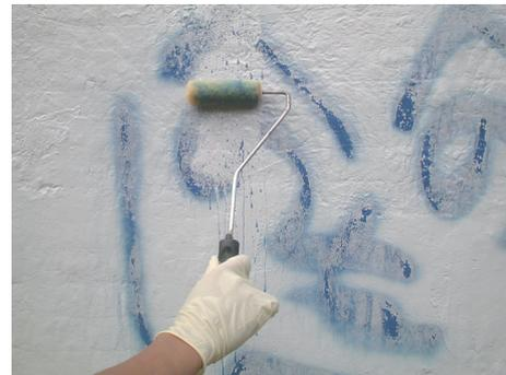
① スカイ洗浄用シンナーを含ませた、中毛ローラーで、落書き部分にシンナーを置いてくるように塗布して下さい。
