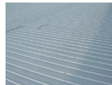
K社・工場(折板屋根)
